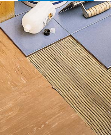
Nakładanie na stare podłoże z PVC
